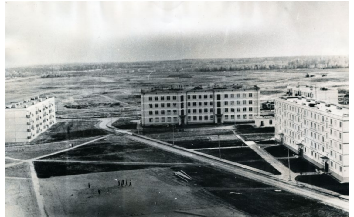
Начало строительства Зеленограда. 1960-е гг.
